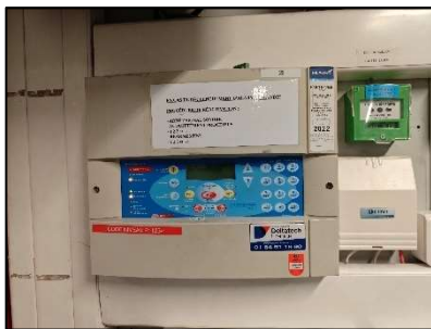
Centrale incendie (Cassiopée Piano-C asservissement impossible sans ajout d'un module)
